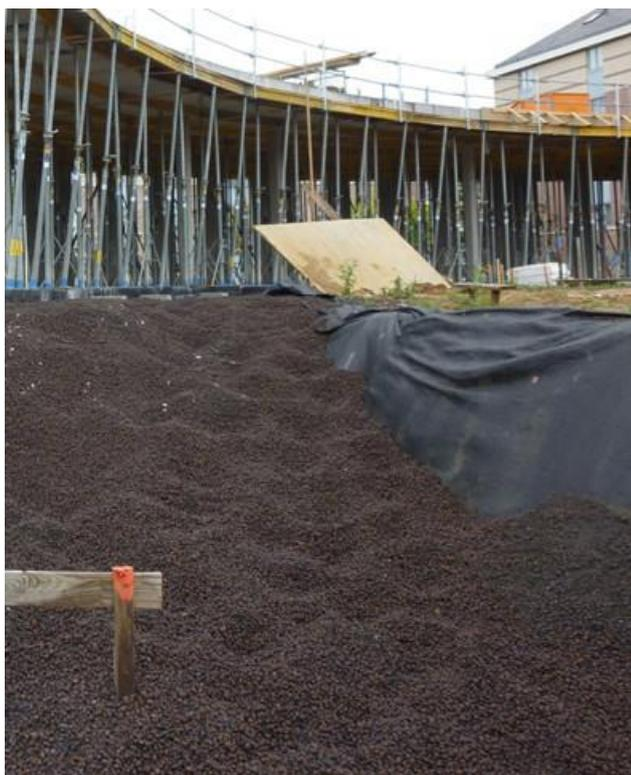
Pose de billes d'argile expansée sur le chantier Bâtiment Exemplaires « Trèfles » - bureau d'architecture ARTER
